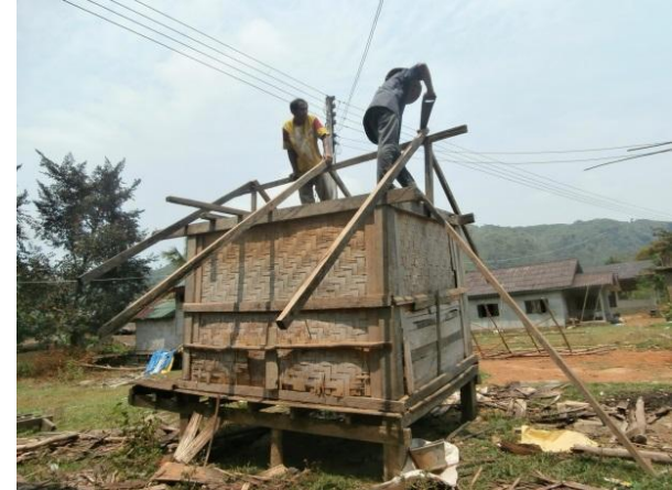
ການກໍ່ສ້າງເລົ້າເຂົ້າ Building rice house ແຂວງວຽງຈັນ Vientiane Province (ບ້ານຄອນເລືອງ)
